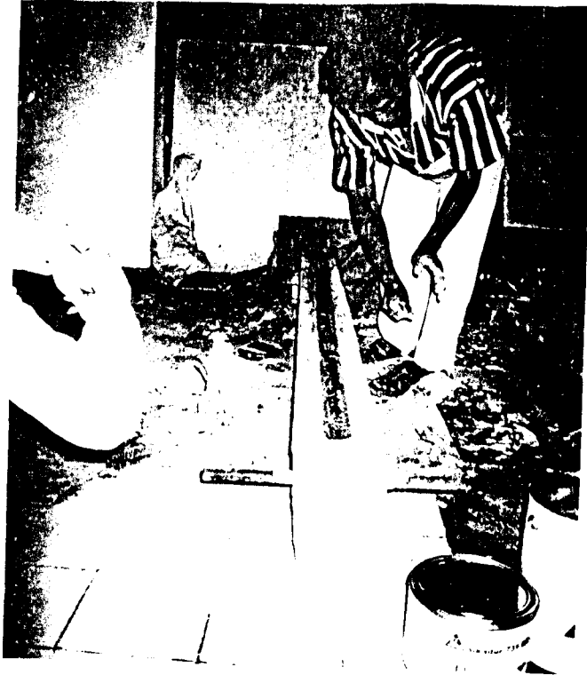
Photo 9. Pelekatan perkuatan plat baja pada balok
