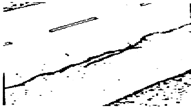
Gambar 3.6 Retak sambungan pelebaran jalan ( widening crack ) Sumber : Silvia Sukirman
