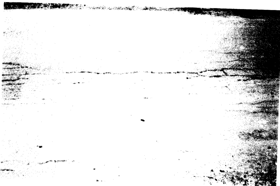
Gambar 4.3. Foto retak alur
