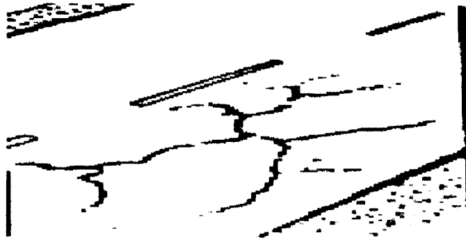
Gambar 3.7 Retak refleksi ( reflection crack ) Sumber : Silvia Sukirman
