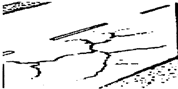
Gambar 3.4 Retak sambungan bahu perkerasan ( edge joint crack ) Sumber : Silvia Sukirman
