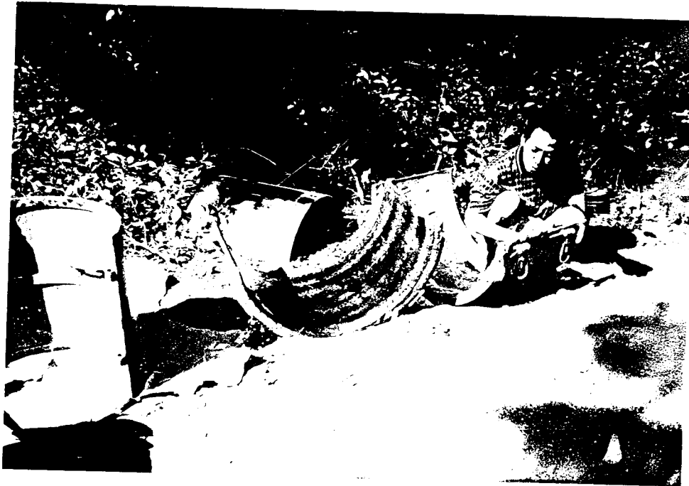
Foto 5 : Persiapan cetakan buis beton dengan melapisi pakai oli
