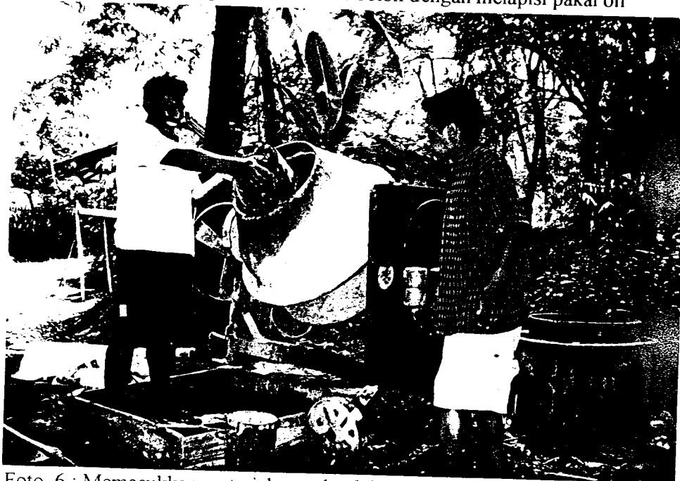
Foto 6 : Memasukkan material yang ke dalam molen sesuai perbandingan campuran.
