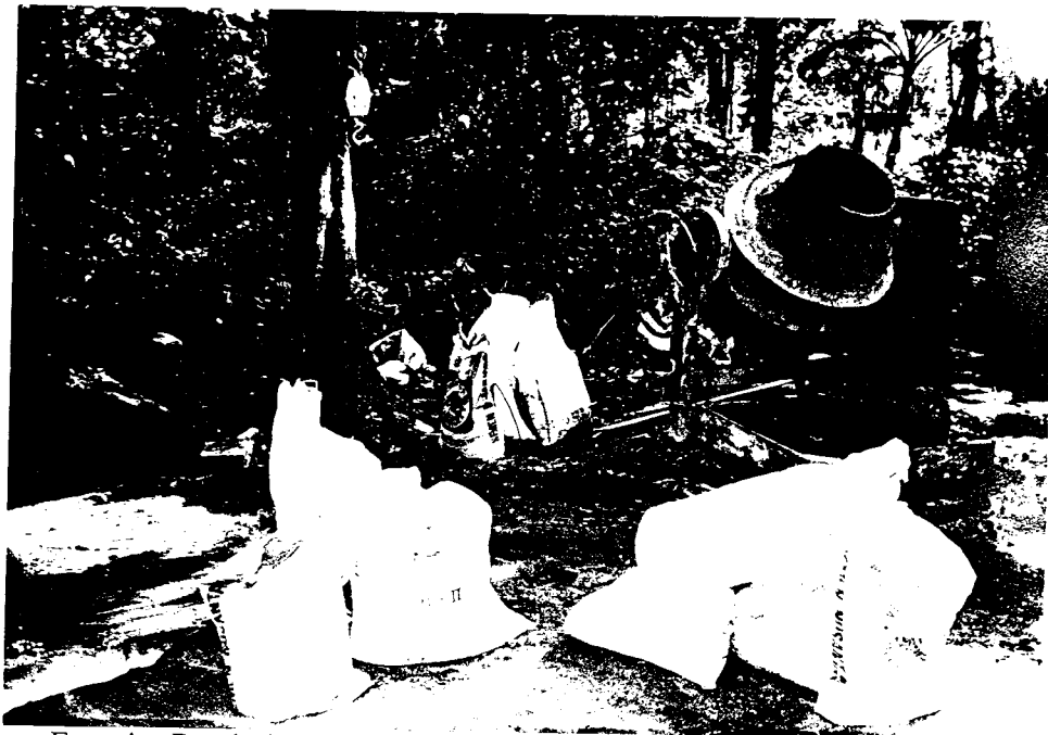
Foto 4 : Pemisahan disesuaikan dengan perbandingan campuran beton.
