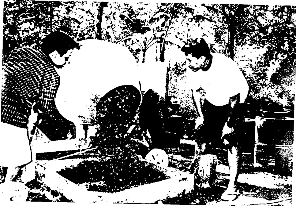
Foto 7 : Campuran beton yang tercampur rata di tuang dari molen
