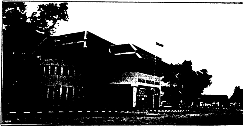
Gambar 2.11 Gelanggang Olahraga Sumpah Pemuda Sumber: Observasi Lapangan
