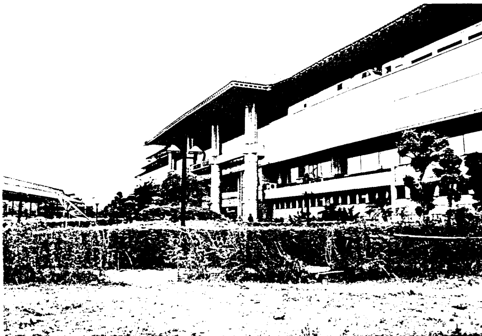
Gambar 2.11. Tampak Stasiun Gambir
