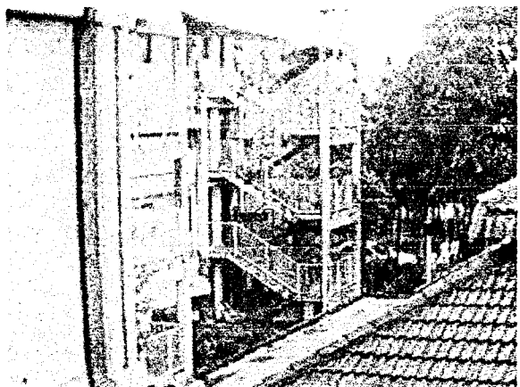
Tangga Sirkulasi Vertikal di Luar Bangunan
