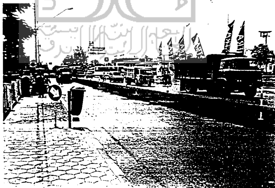
Pemasangan Paving Block dengan Kerb
