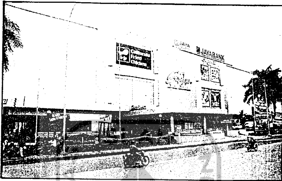
Gambar 2.24 : Fasade Bangunan SJP, Jakarta Sumber : Majalah Konstruksi 142, thn 1990
