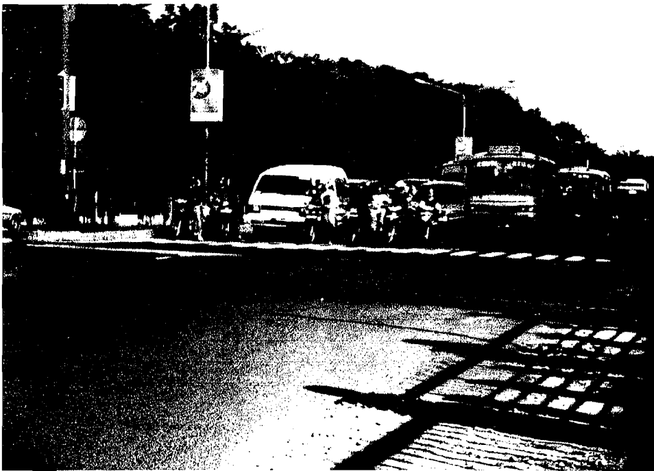
Ruas Jalan Ring Road Utara bagian Barat (Gambaran Umum Lengan)
