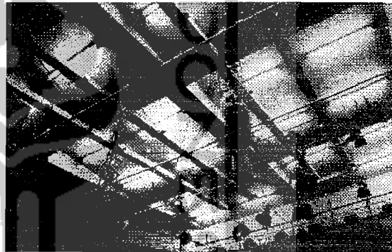
Gbr 2.14 Langit-langit studio dengan instrumen lighting yang digantung dengan menggunakan pantograph di Studio PUSKAT Sinduharjo (Sumber: dokumentasi)
