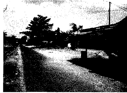
Kondisi jalan utara site, dapat dilalui kendaraan roda 4 dan kondisi lalulintas tidak ramai
