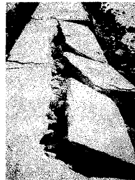
Gambar III.6 Foto Kondisi Jalan Dermaga
