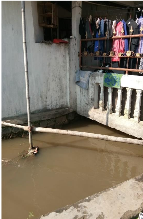
Saluran Air di Bawah Teras Rumah
