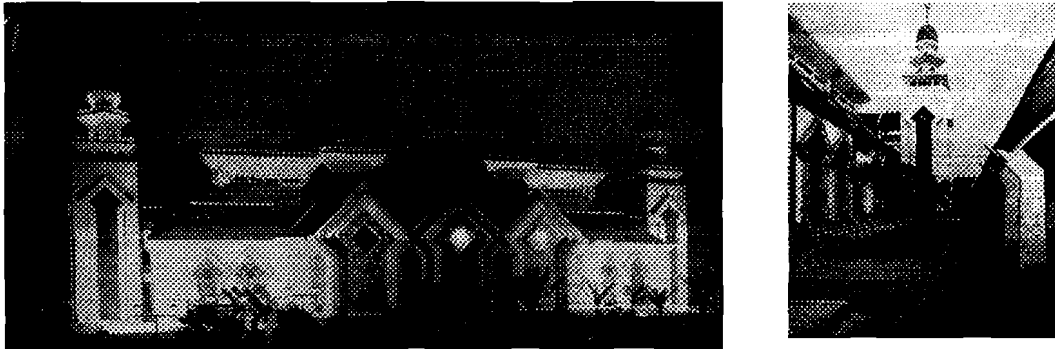
Gbr.1.9.1.Masjid At-Tin Taman Mini Indonesia Indah
