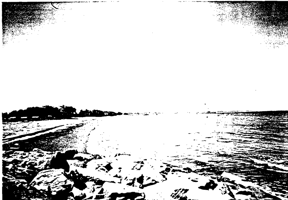
KONDISI TEPI PANTAI DAN PEMECAH GELOMBANG
