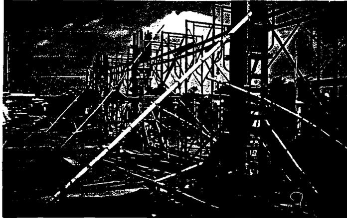
**Gambar 5.3 Pemasangan bekisting kolom**
