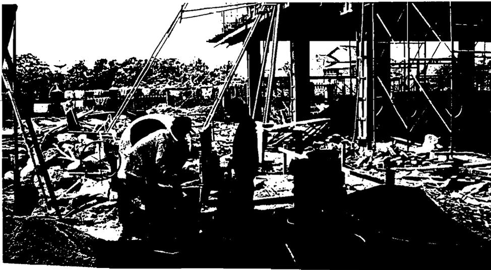
**Gambar 4.1 Mesin Aduk Beton**
