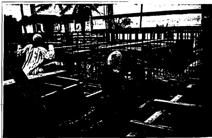
**Gambar 5.5 Penulangan balok lantai**
