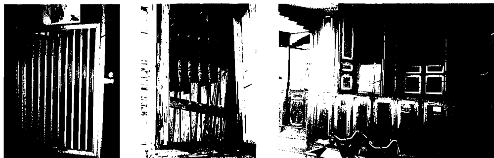
Gb. 2.18. Variasi lalunggang pada rumah Banjar (Sumber: Dokumentasi Lapangan, 2004)
