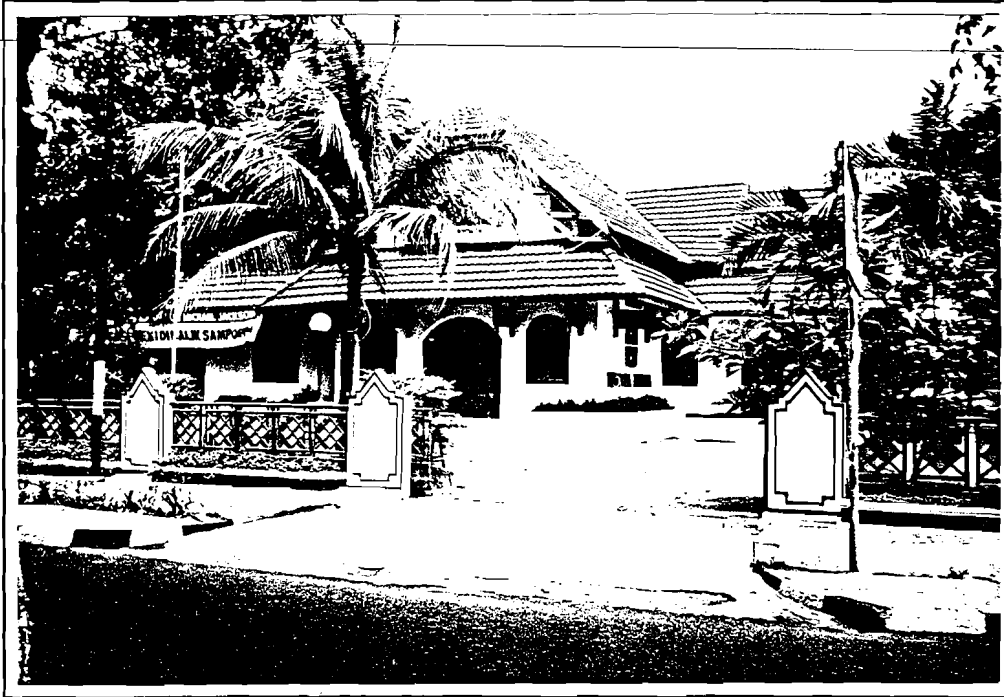
Gedung Bentara Budaya Gedung yang kurang representatif, baik dari segi penempatan maupun penampilan bangunan
