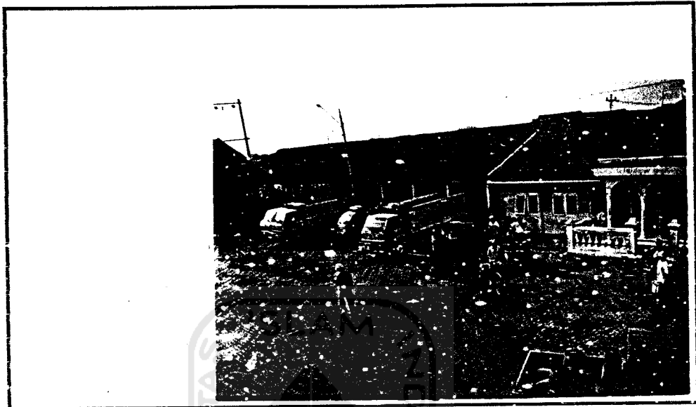
Gambar III.34 : Penampilan bangunan Sumber : Analisa
