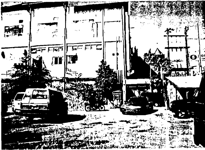
• VIEW DR ARAH BARAT KE TIMUR (LAWA) (MENGHADAP KE ARAH BANGUNAN TOKO TEKSI)
