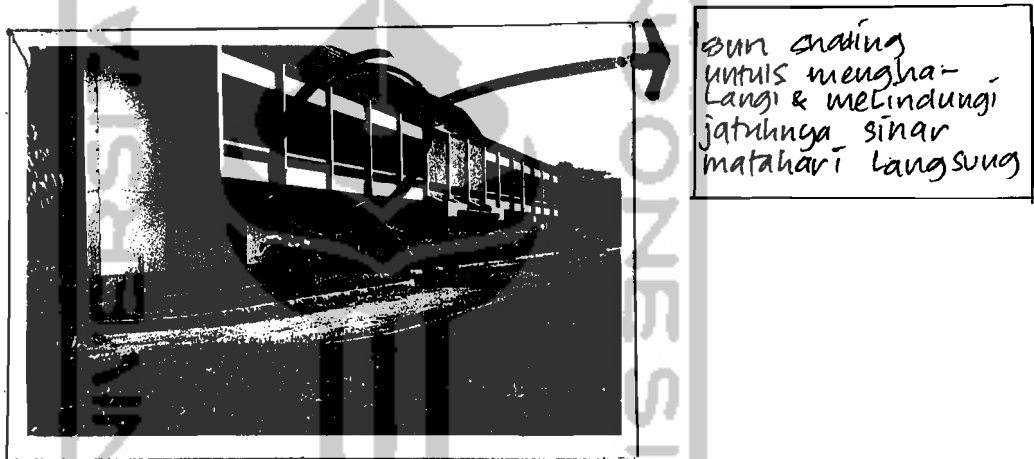
Gbr.2.5. Penggunaan tritisan dan sun shading pada bangunan tropis
