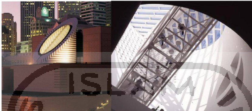
Gambar material bata pada selubung bangunan dan kaca, baja pada bagian Oculus.
