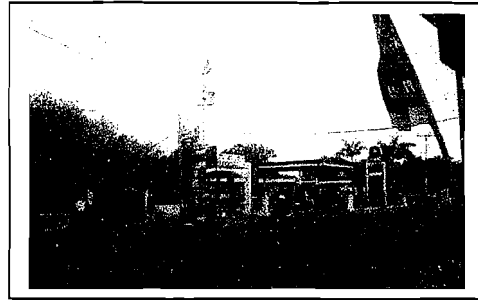
Gambar 23 : Foto Site terpilih 2 Sumber : Dokumentasi
