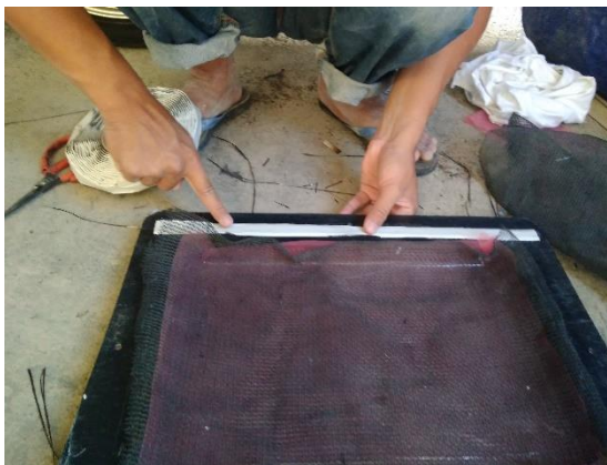
Gambar 3.13 Pemasangan sealent tape
