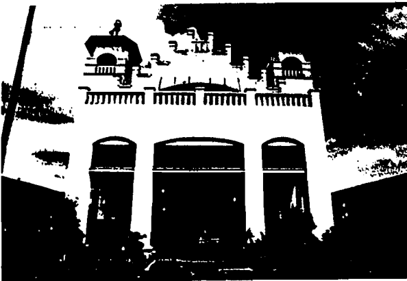
Foto Nomor 3/100295 Bangunan tengah (utama) dengan dua buah menara di kanan kiri bangunan, dilihat dari barat daya
