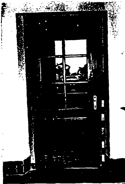
Foto no.76/100436 Kondisi pintu masuk ruang de- pan (R1) sisi utara, dilihat lihat dari utara
