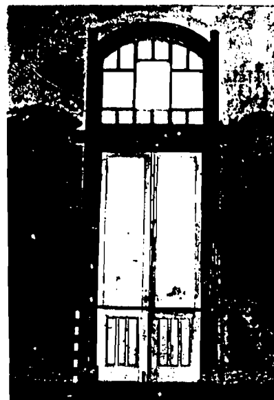
Foto Nomor 36/100392 Detail pintu dan boven di ruang hall sisi utara dan selatan di- lihat dari dalam
