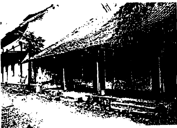
Foto Nomor 41/100340 Kondisi bangunan belakang bangun- an utama, dilihat dari barat daya
