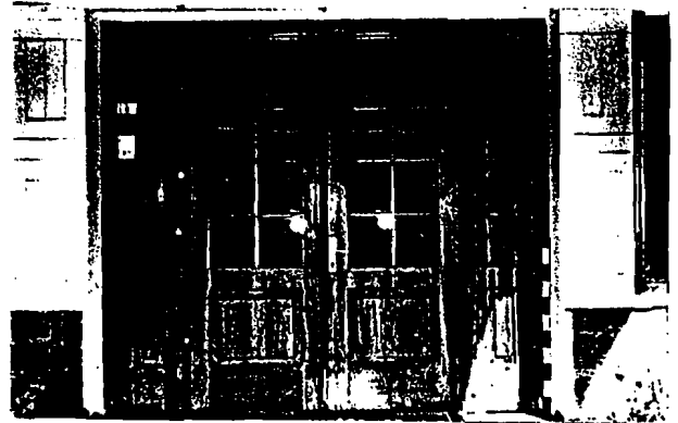
Foto no.77/100440 Kondisi pintu masuk ruang de- pan (R1) sisi barat, tampak luar, dilihat dari barat
