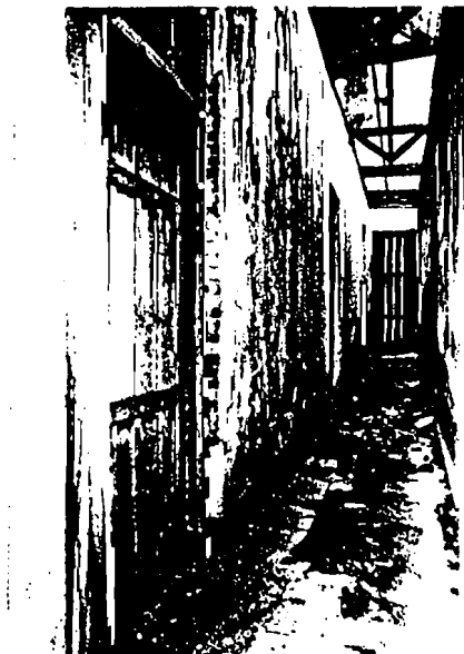
Foto Nomor 40/100397 Kondisi lorong belakang bangun- an utama, dilihat dari timur
