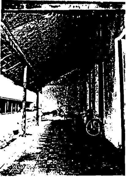
Foto Nomor 43/100349 Kondisi "emperan" bangunan belakang, dilihat dari selatan
