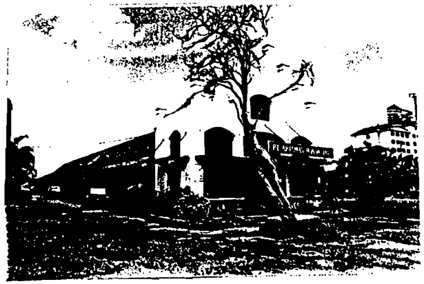
Foto no.65/100417 Kondisi bangunan sisi selatan dilihat dari barat laut
