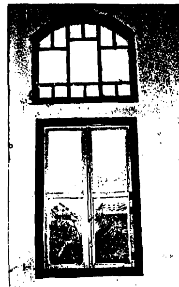
Foto Nomor 18/100338 Detail jendela dan bovenlight tampak dalam di ruang lobby
