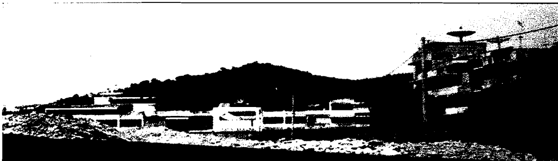
gambar 16 : bangunan sebelah barat site sumber : survey lapangan
