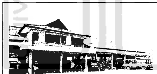
gambar 1.3 Bangunan Utama terminal Sumber : Obsevasi 2006
