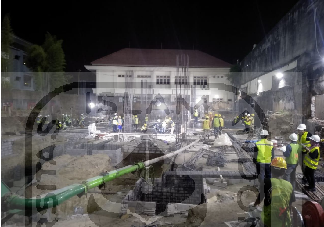
Gambar L-3.9 Proses Pengecoran Pekerjaan Struktur Bawah Pada Proyek Manohara Hotel Yogyakarta
