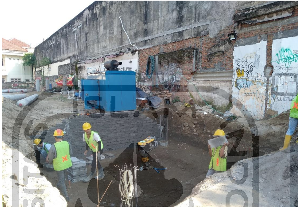
Gambar L-3.3 Proses Pemasangan Bekisting Untuk Pondasi Tower Crane
