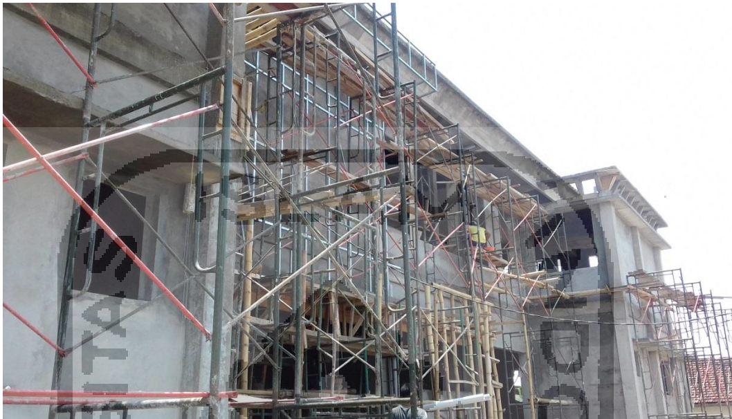
Gambar 1 : Proyek pembangunan Gedung Puskesmas Tladan
