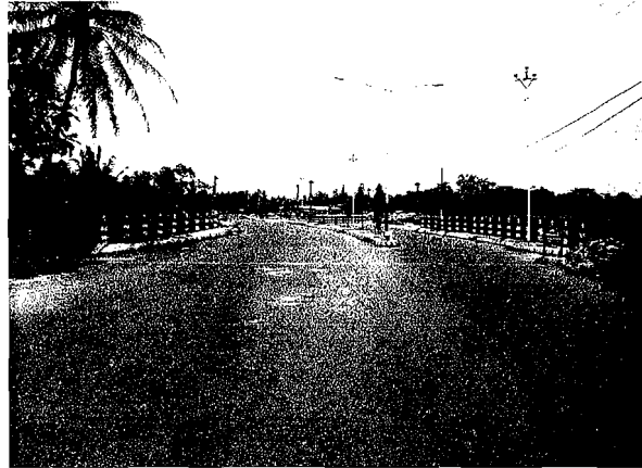
Gamb.1 Pintu masuk timur kawasan stadion ( Lokasi Site )
