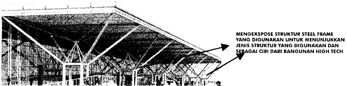
Gambar III-30 Struktur space frame pada bangunan high tech
