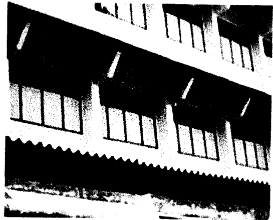
Gambar 4.53 Ruang Kuliah II/06 tampak dari luar
