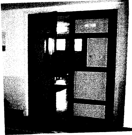
Gambar 4.87 : Pintu Ruang Sampel DI/3
