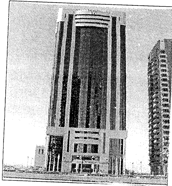
Gambar 3.29. Gedung Rotana hotel 28
