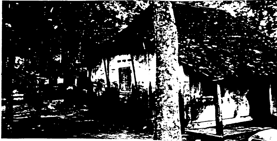
Gambar III.8 Bangunan utama dari entrance sebelah barat
