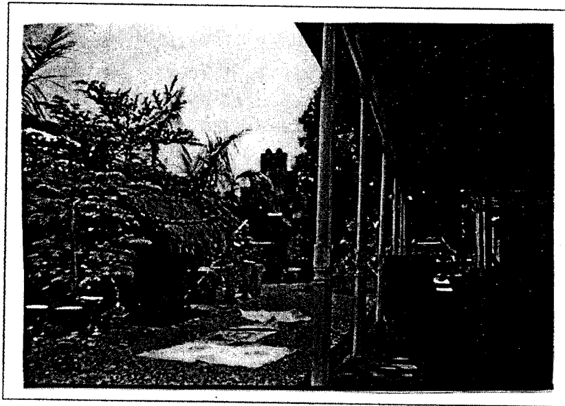
Gambar 3.4 : Tampak Depan Bangunan Tradisional Jawa Omah Dhuwur Gallery dan Entrance Belakang, dilihat dari arah samping timur Sumber: Dokumen pribadi, 2001
