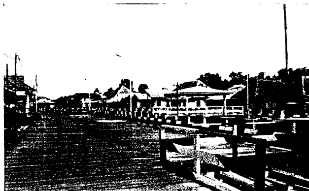
3.7 Open space yang terbuat dari titian kayu Sumber : survey 2006
