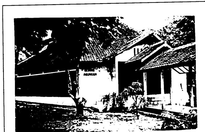
Gambar 1.4. Bagian belakang bangunan aquarium yang dipergunakan untuk meletakkan aquarium
