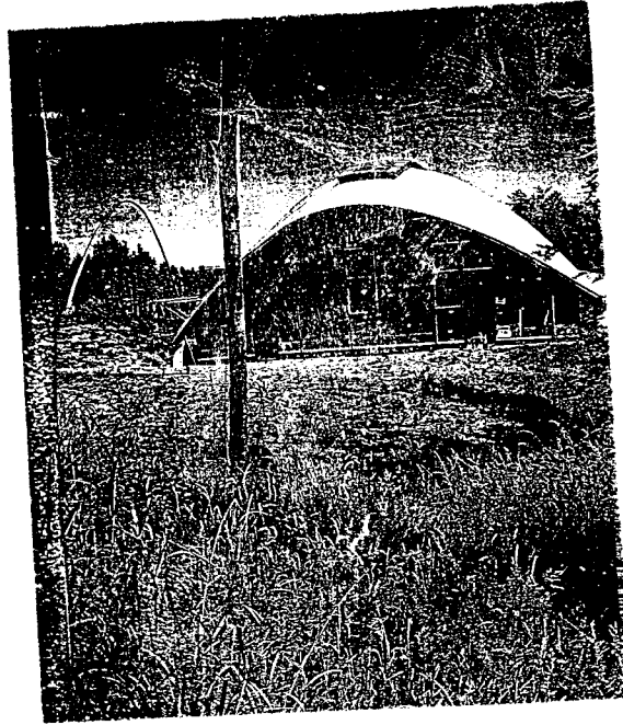
Gambar 4.3. Bangunan dengan karakter yang menonjol
