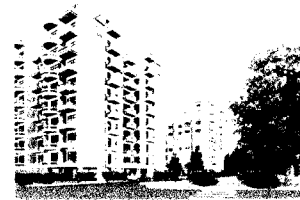
Balkon sebagai shading dan sirip
