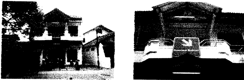
Gambar II.4.i Bangunan Gayam 16 di lihat dari Utara, Studio lantai dua terletak di lantai 2 bangunan
