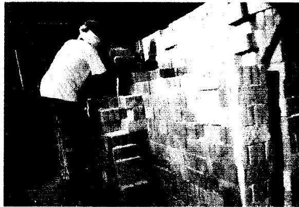
Gambar A.5 Pembongkaran/pengambilan bata
