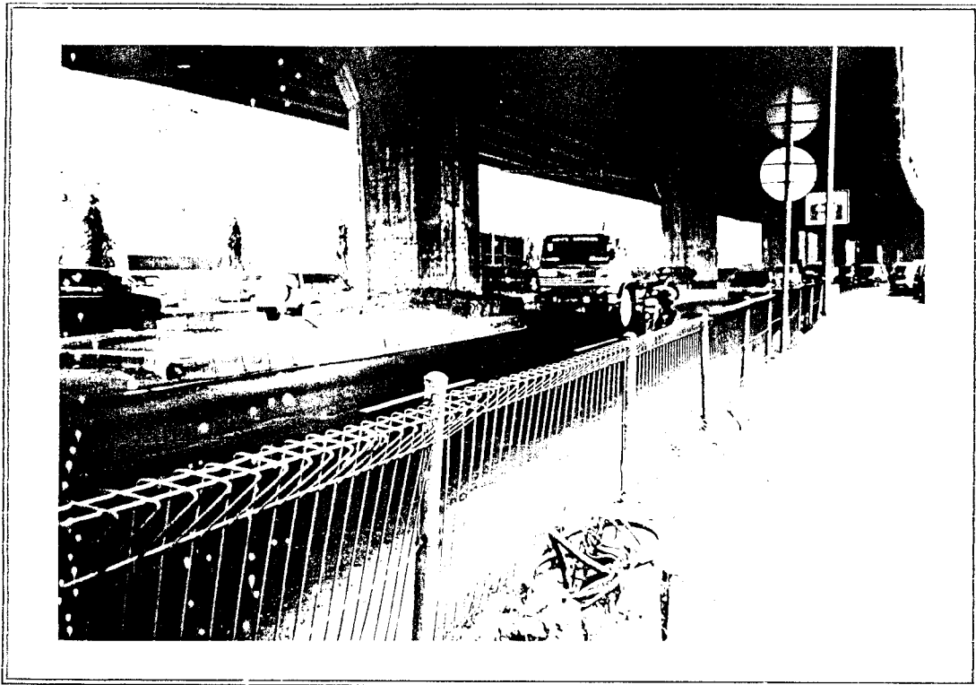
Gambar 7.5 Pembatas antara lajur tol dengan jalan arteri
