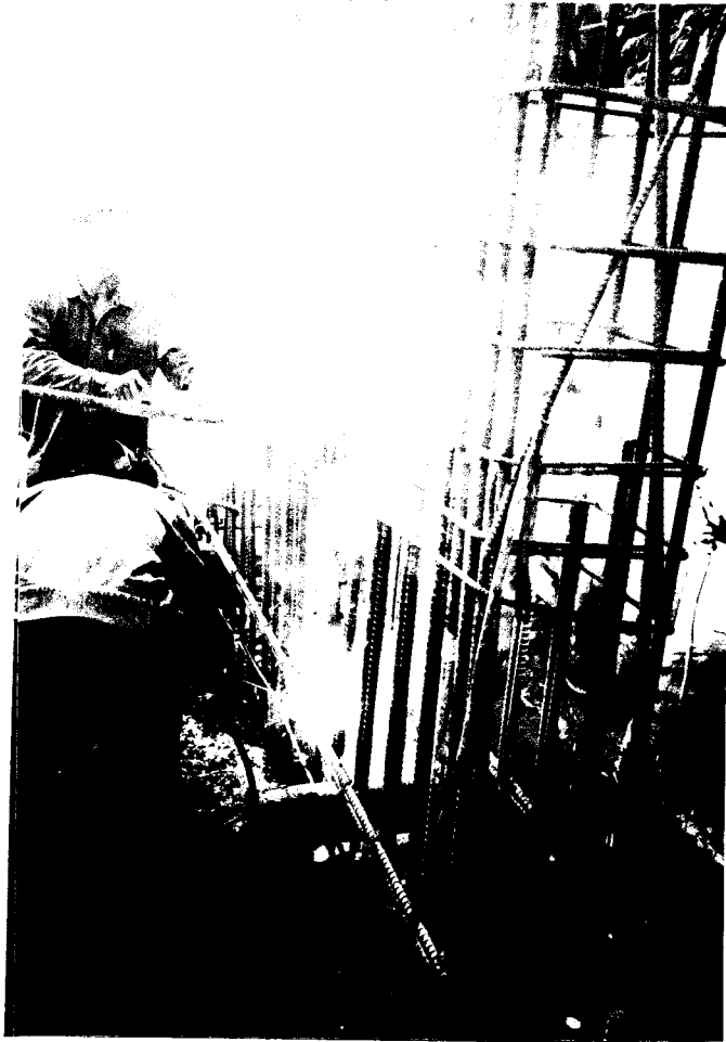
Gambar 5.15. Pengelasan saat penyambungan panel
