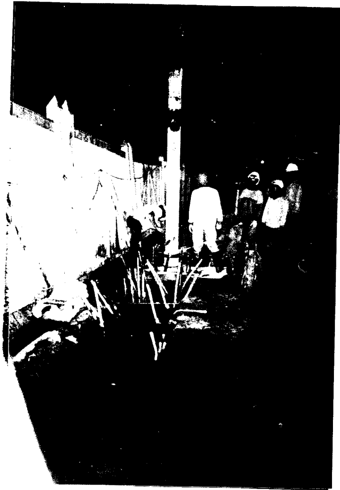
Gambar 5.17. Pemasangan pipa tremie
