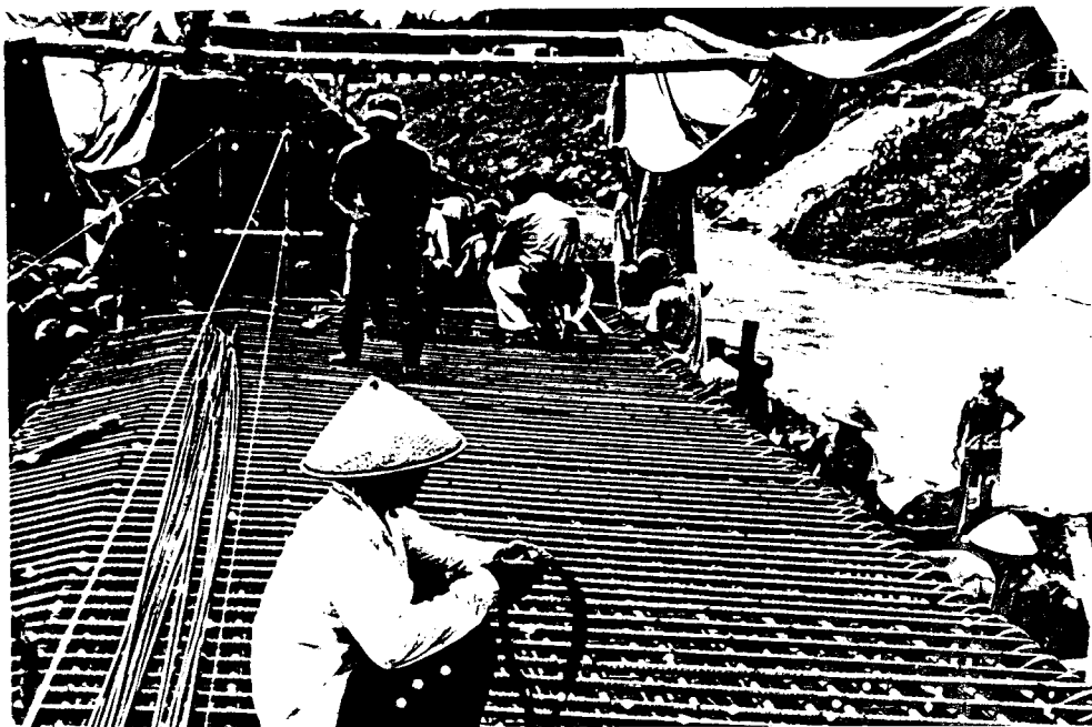
Gambar Pejulangan Lantai Jembatan
