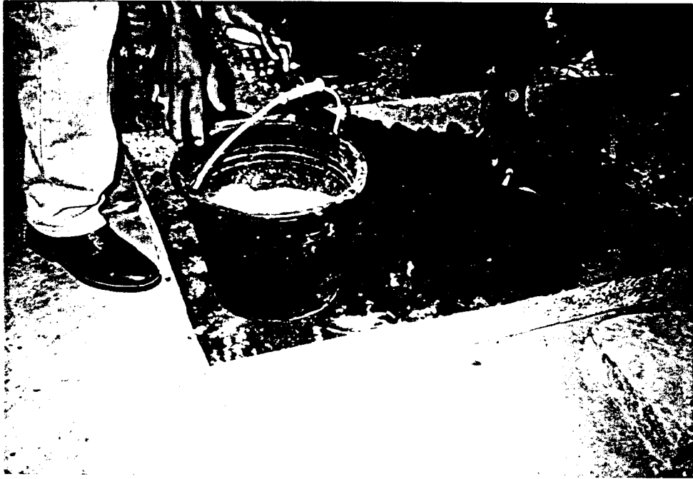
Foto pelaksanaan campuran beton
