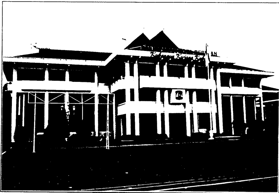
Kantor PEMDA Tingkat II Balikpapan Di Jalan Jend. Sudirman
