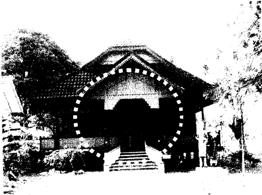
Gambar 4.5 fasad rumah adat
