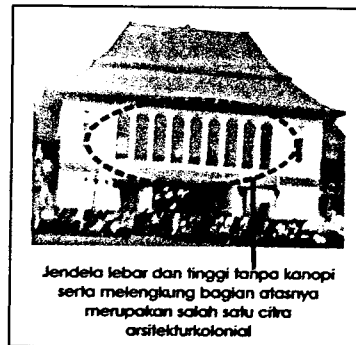
Gbr. I-26. Tampak Bangunan Pasar Gede
