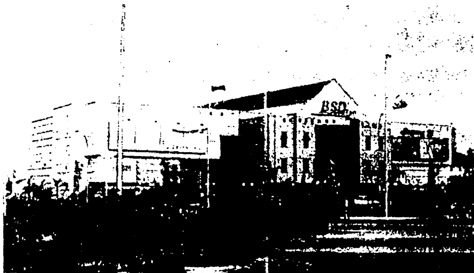
Gambar 2.10 : BSD Plaza, bangunannya unik dan meriah. Sumber : Majalah Konstruksi, edisi Agustus 1993
