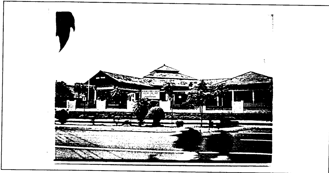
Gambar 3.15a. Bangunan dengan tipe Tajug yang ada di Surakarta Sumber : Hasil Pengamatan Lapangan
